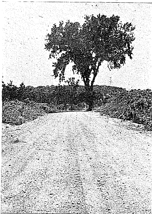
Fig. 16. — Estado de Nueva York. Camino estabilizado con ligante arcilla-agua y cloruro de calcio.
